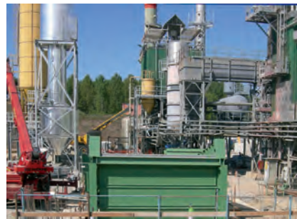
Installazione griglia termovalorizzatore. Installation of the grate of a waste to energy plant.
